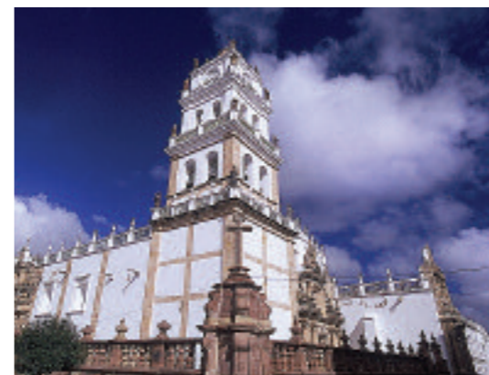
La Catedral de Sucre fue construida en 1559, con una mezcla de estilos renacentistas, barrocos y neoclásicos.
